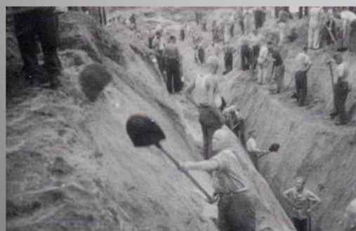
Achèvement de la tranchée du Boivre à Saint-Brevin-les-Pins par les prisonniers allemands à l'été 1945
