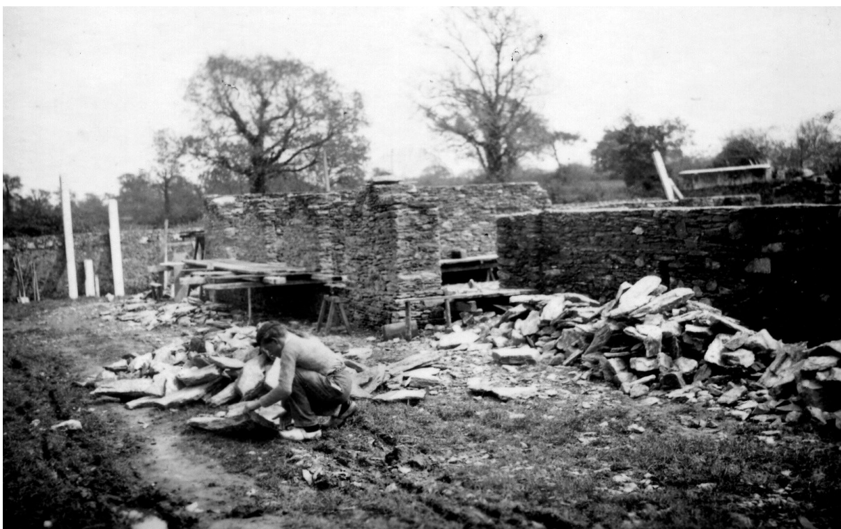
Coco Landry sur le chantier de la salle Saint-Roch (coll. M. Landry)
