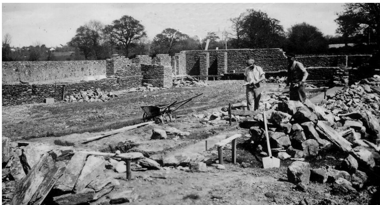
Francis Bourreau et Albert Renaudin sur le chantier de la salle Saint-Roch en 1936 (coll. M. Landry)
