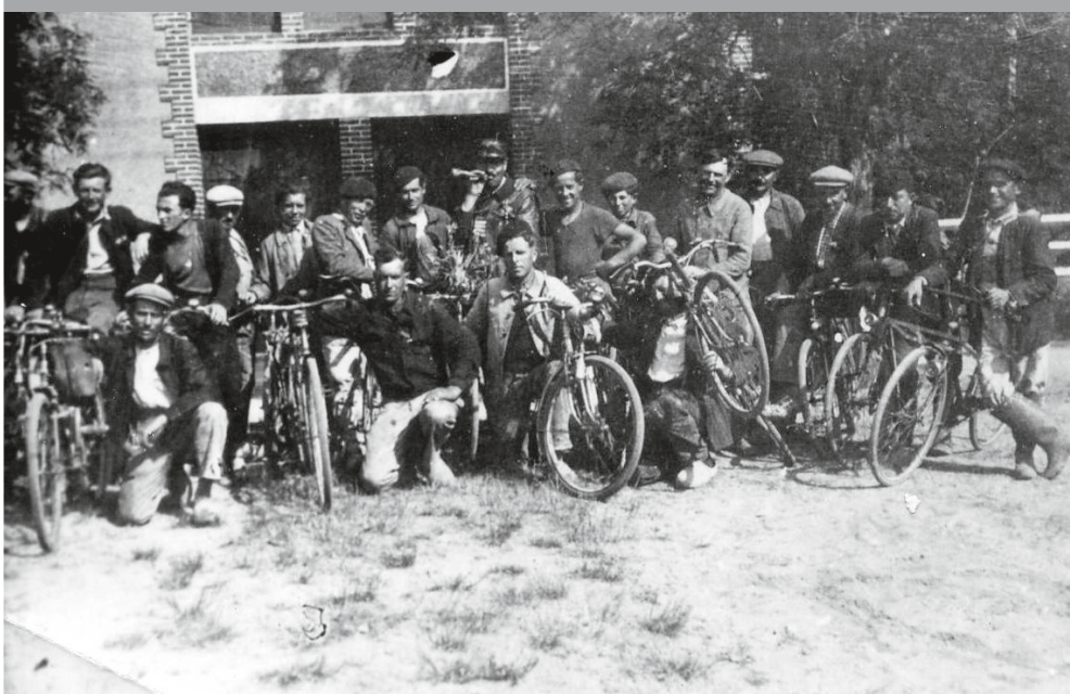
Un groupe de travailleurs réquisitionnés de Saint-Père-en-Retz s'approprient à partir sur le chantier de la tranchée antichars de la Clercière au printemps 1945.
